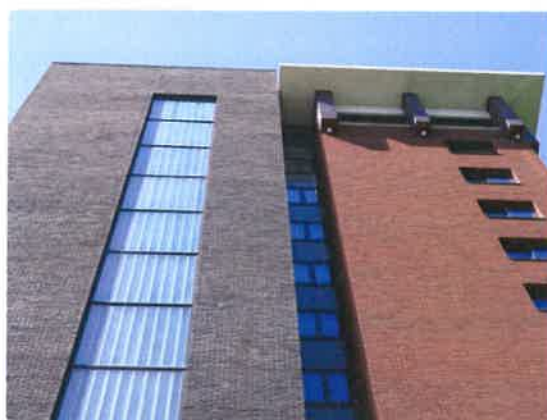
2. Bastionhotel Eindhoven Laan v Diepenvoorde 30
