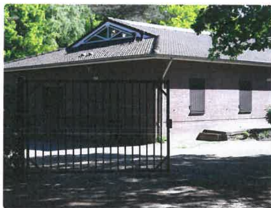
4. Blokhut de Meerberg / Scouting A-W Heistraat 64
